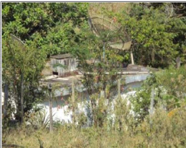
FOTO 11: Edificação de 50,90m 2 de área com estrutura em concreto armado.
