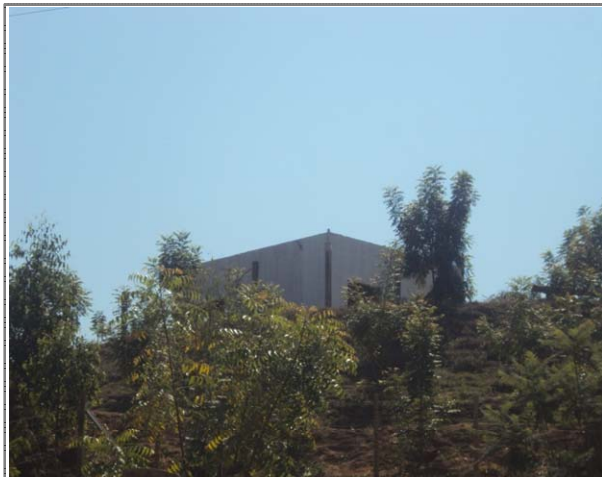
FOTO 05: Edificação de 25,90m 2 em alvenaria com lage em processo de acamento, sem portas e janelas.
