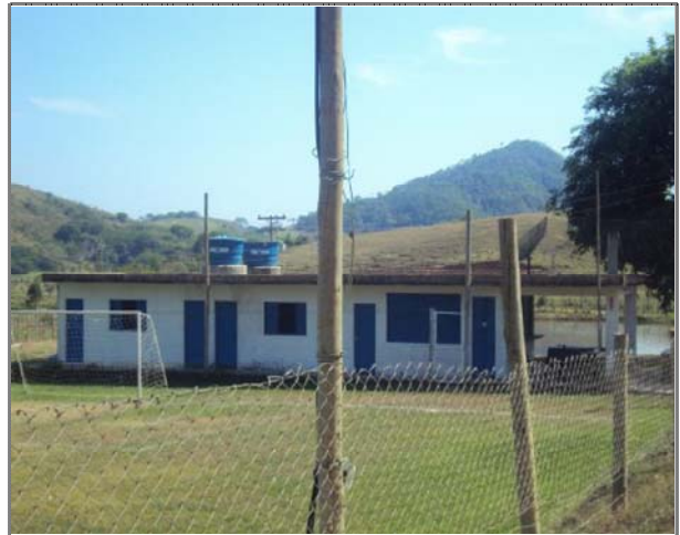
FOTO 04: Abrigo do campo de futebol com 85,35m 2 de área edificada em estrutura de concreto com laje.
