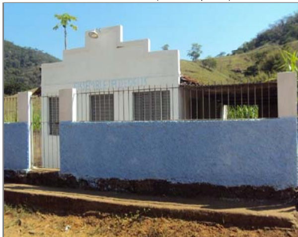
FOTO 15: Assembleia de Deus em alvenaria e telhado com telha de barro. Área 45,15m 2 .
