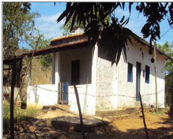
FOTO 16: Residência em alvenaria. Área de 57,68m 2 .
