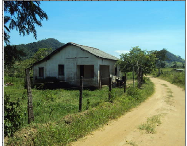
FOTO 08: Residência de 57,03m 2 em alvenaria e telhado em telhas de barro.
