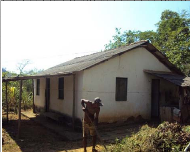
FOTO 07: Residência de 45,17m 2 , em alvenaria e telhado em telhas de amianto.
