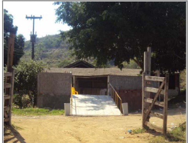
FOTO 02: Ponto comercial de 74,80m 2 em alvenaria com cobertura parte em telhas de amianto e parte em telhas de barro.
