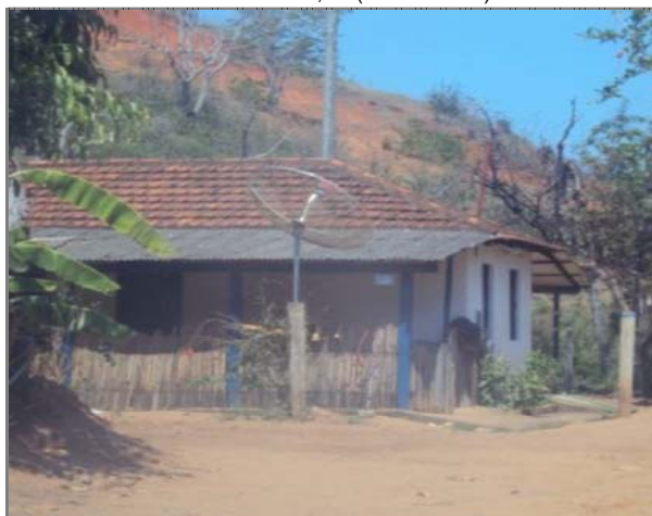
FOTO 13: Residência de alvenaria e telhado com telhas de barro. Área da edificação: 121,31m 2 .
