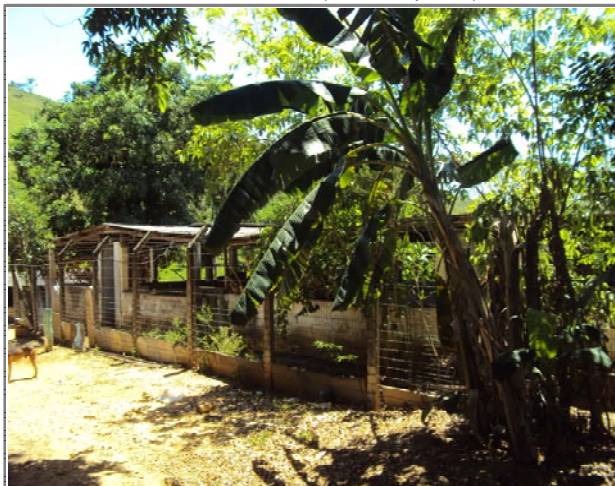
FOTO 19: Edificação com colunas e arame e cobertura com telhas de amianto. Área 94,48m 2 .
