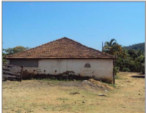
FOTO 06: Depósito de insumos para animais, em alvenaria com 166,78m 2 de edificação e um curral com área de 53,03m 2
