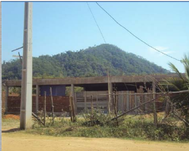
FOTO 09: Edificação de 107,69m 2 de área em construção.
