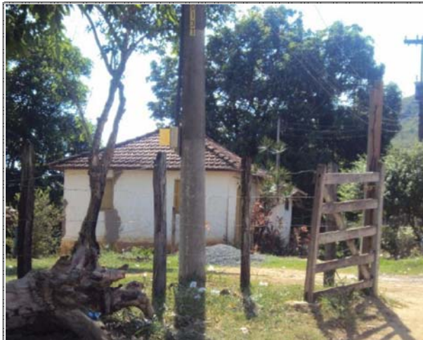
FOTO 03: Residência de 49,30m 2 em alvenaria com cobertura de telhas de barro.
