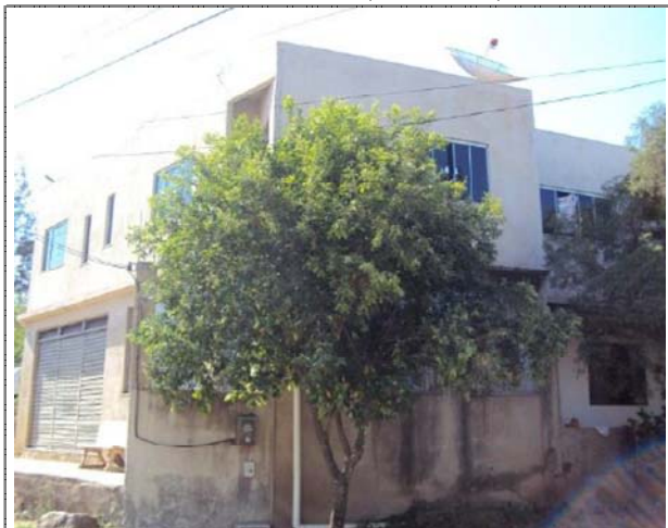
FOTO 23: Edificação em alvenaria. Área 108,24m 2
