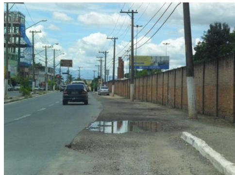
Fotografia 4: Água empossada no acostamento
